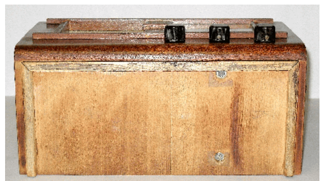
Bild 20: Chassis-Befestigung mit ungeschützten Bodenschrauben
