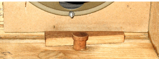
Bild 24: Holzkeil und Stützpilz zum Einklemmen der Schallwand
